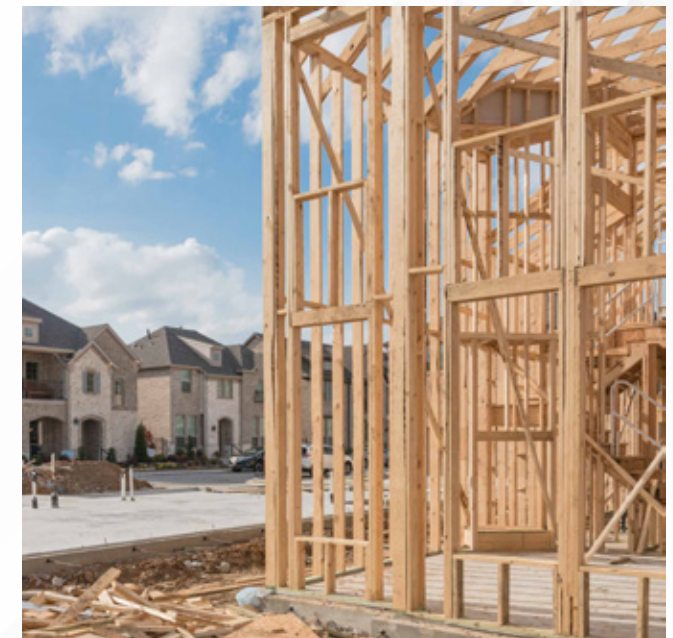
Sistema constructivo balloon frame . Fuente: Storables
