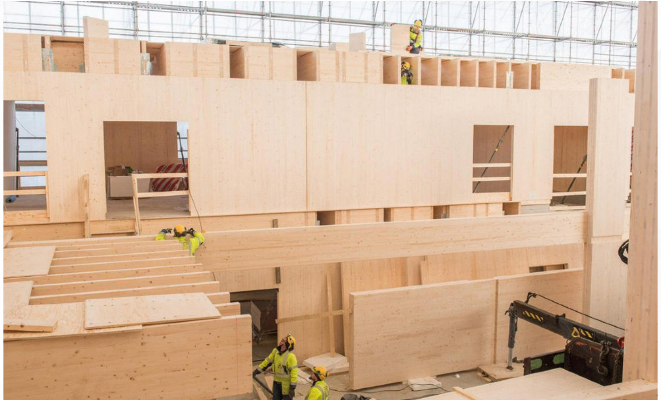
Sistema constructivo CLT. Fuente: Madera21
