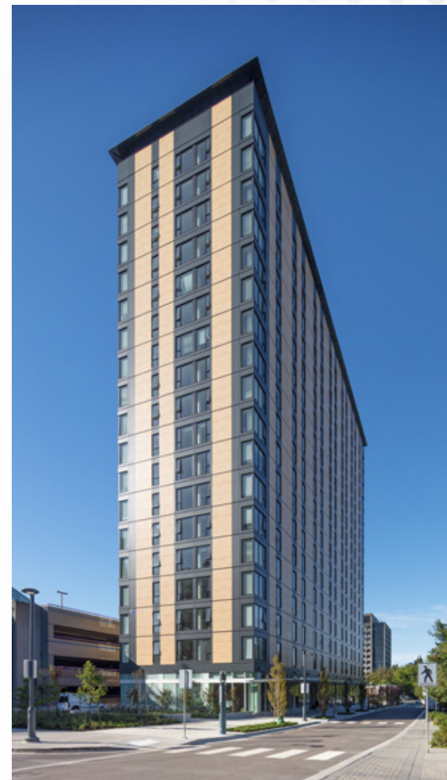
Edificio híbrido Brock Commons, Vancouver. Imagen: University of British Columbia
