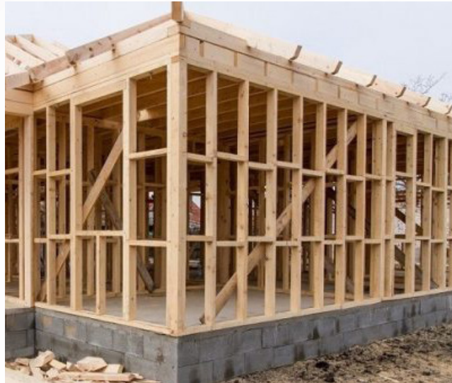
Sistema constructivo marco-plataforma Fuente: Madera21
