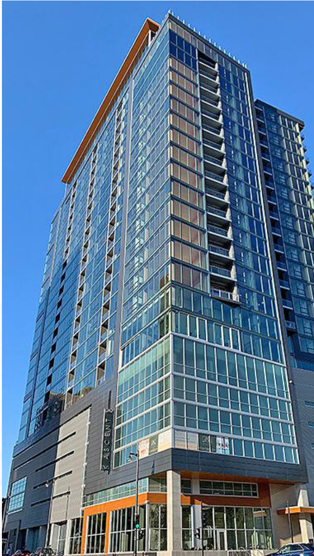
Edificio Ascent, Wisconsin (EEUU). Imagen: thorntontomasetti.com
